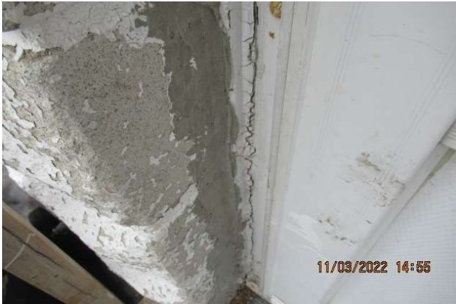
Scellant au pourtour des ouvertures à entretenir
