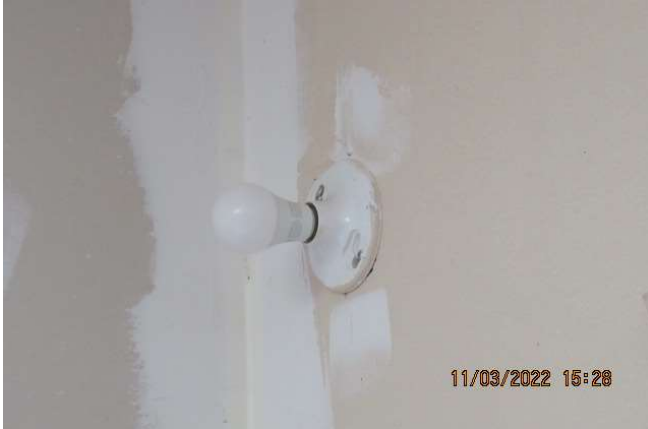
Ampoule sans globe de protection
