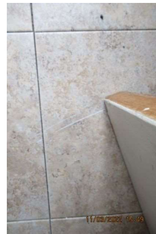
Défectuosité de la porte
