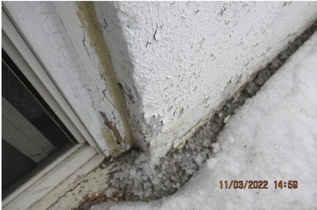
Scellant au pourtour des ouvertures à entretenir
