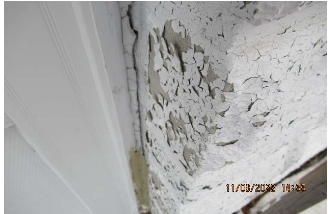
Scellant au pourtour des ouvertures à entretenir
