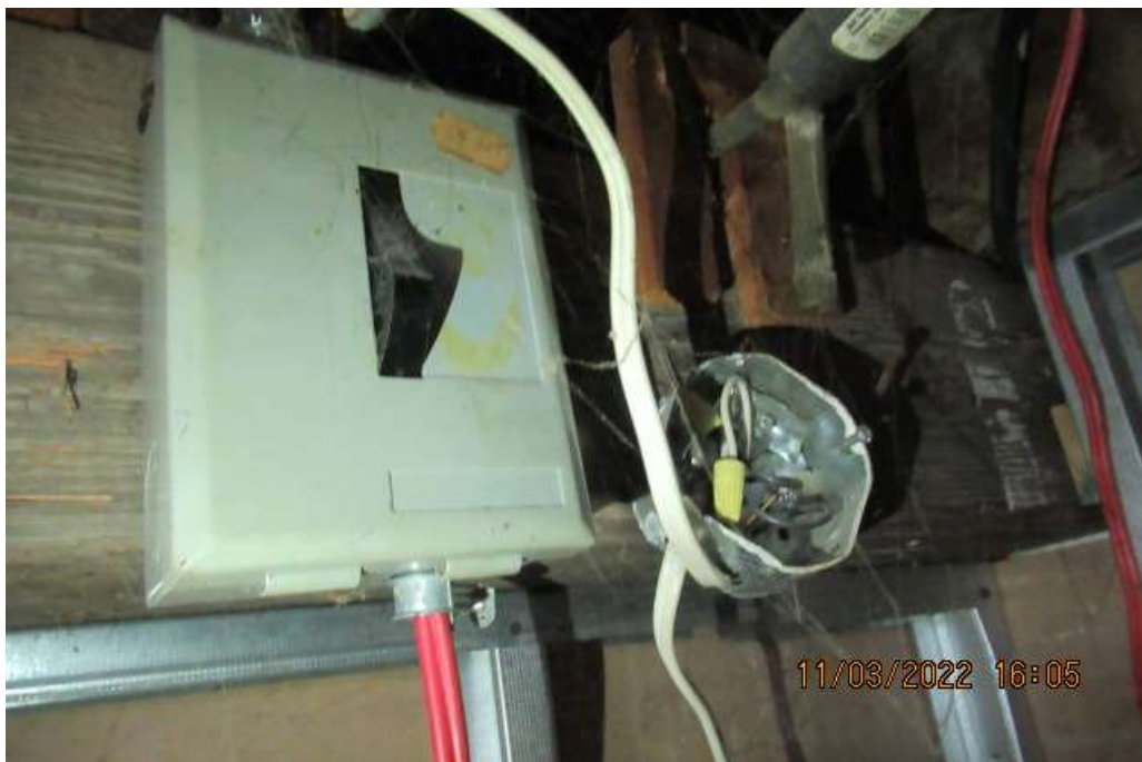
Boîtier électrique sans couvercle de protection
