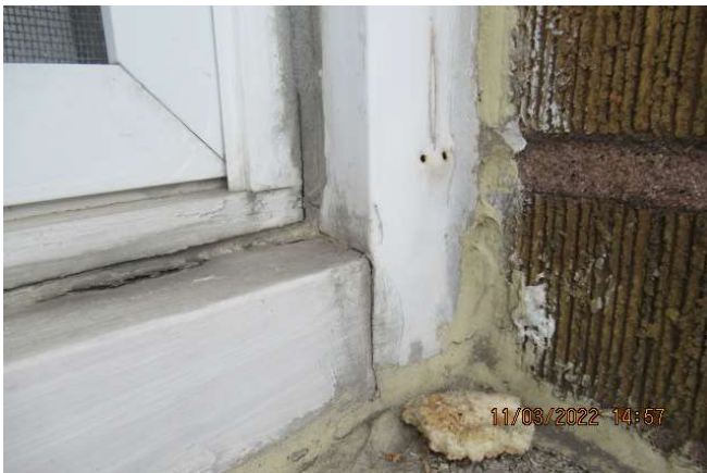
Scellant au pourtour des ouvertures à entretenir
