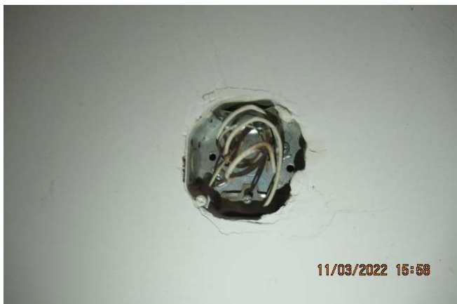
Boîtier électrique sans couvercle de protection
