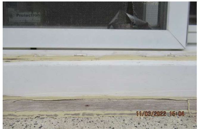
Scellant au pourtour des ouvertures à entretenir
