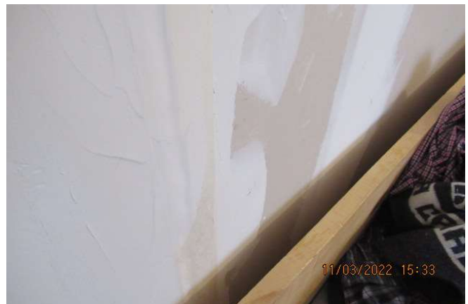
Finition des murs à compléter
