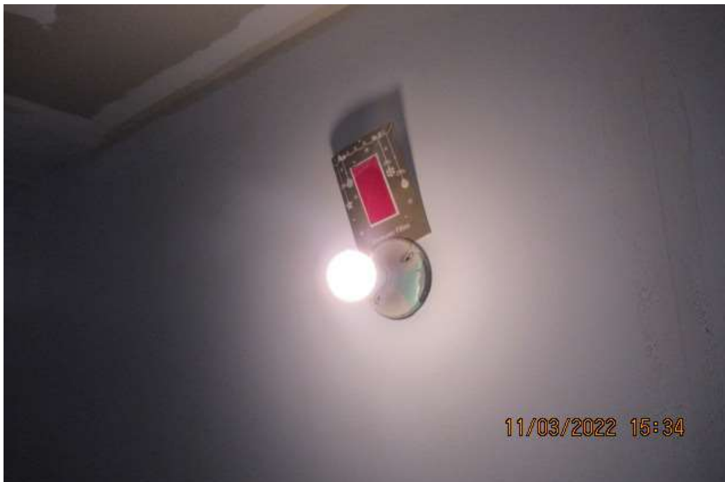
Ampoule sans globe de protection
