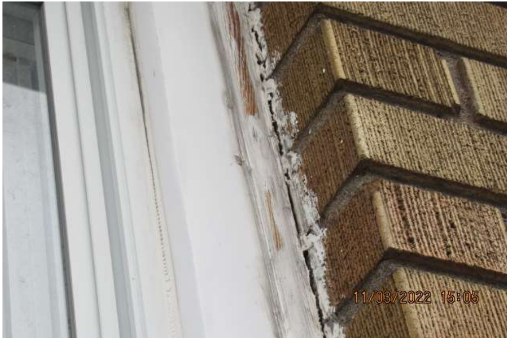
Scellant au pourtour des ouvertures à entretenir
