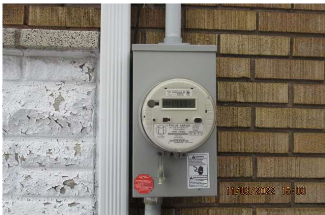
Compteur électrique "intelligent"
