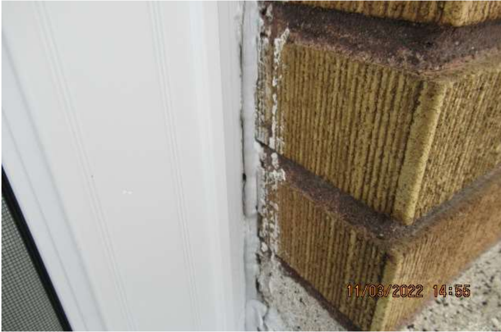
Scellant au pourtour des ouvertures à entretenir
