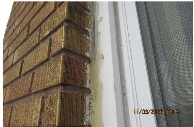
Scellant au pourtour des ouvertures à entretenir
