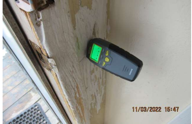
Trace d'eau et cerne sur le mur de l'entrée principale
