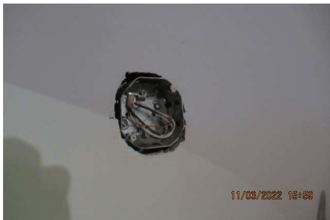
Boîtier électrique sans couvercle de protection
