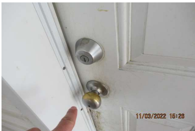
Poignée de la porte est mal ajustée
