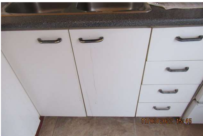
Charnière des armoires à ajuster
