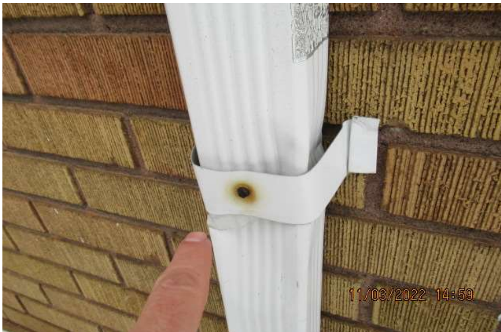
Descente pluviale mal fixée et endommagée
