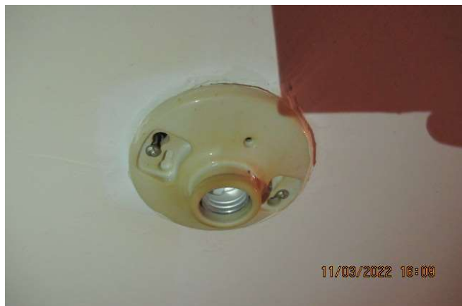
Ampoule sans globe de protection
