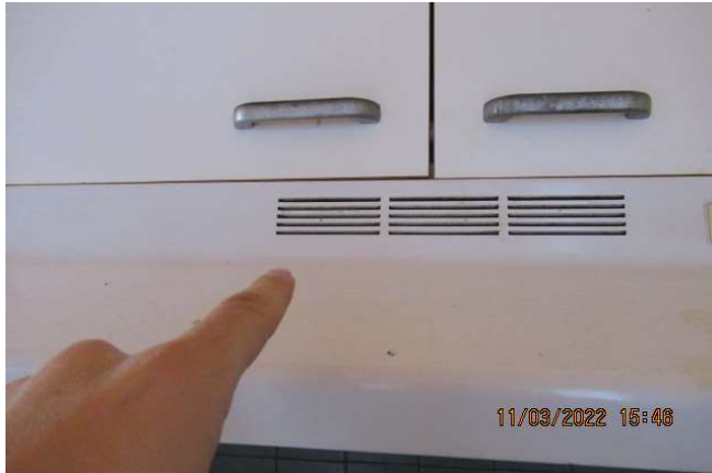
Ventilateur de poêle rejette son air à la cuisine
