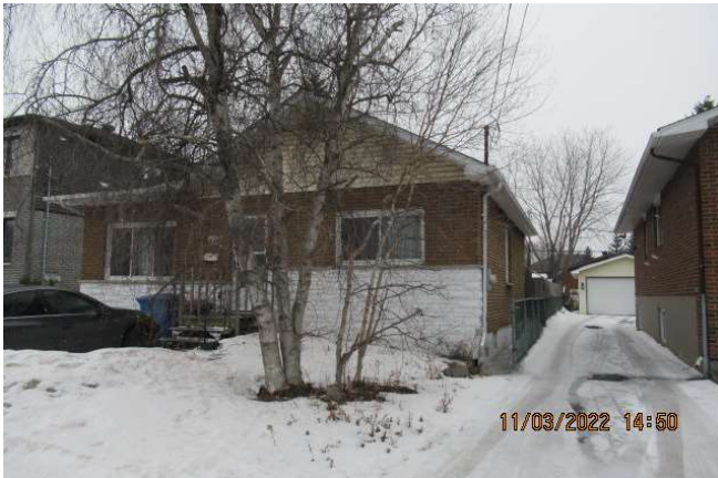
Terrassement caché par la neige
