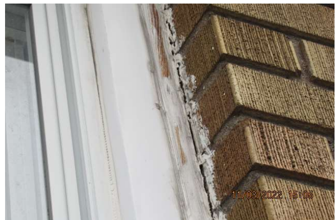
Scellant au pourtour des ouvertures à entretenir
