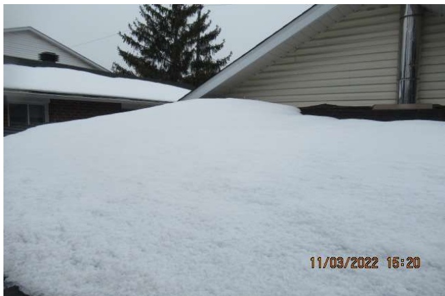
Limitation d'inspection de la toiture
