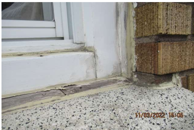
Scellant au pourtour des ouvertures à entretenir
