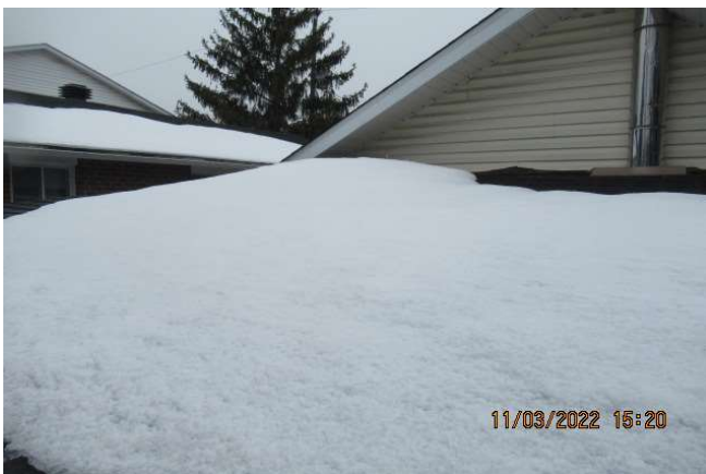
Limitation d'inspection à cause de la neige
