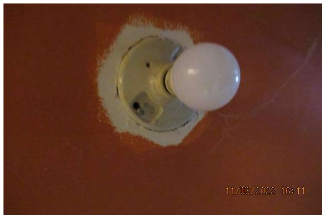
Ampoule sans globe de protection
