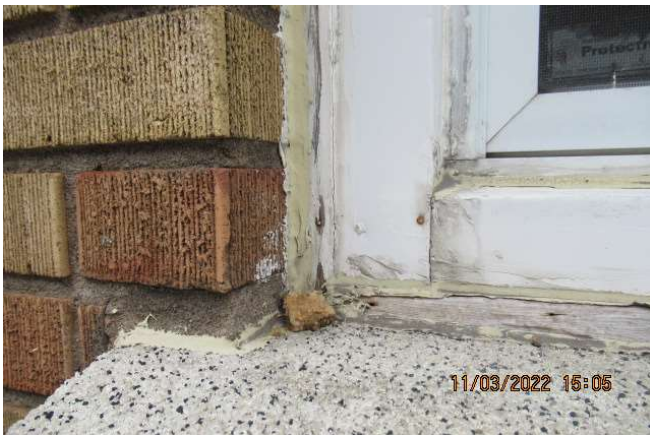
Scellant au pourtour des ouvertures à entretenir
