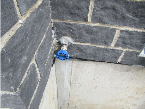
Aucun dommage observés sur les robinets extérieurs
