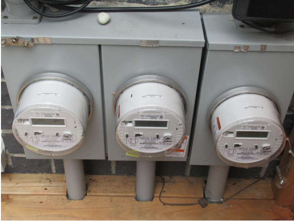
Compteur électrique "intelligent"
