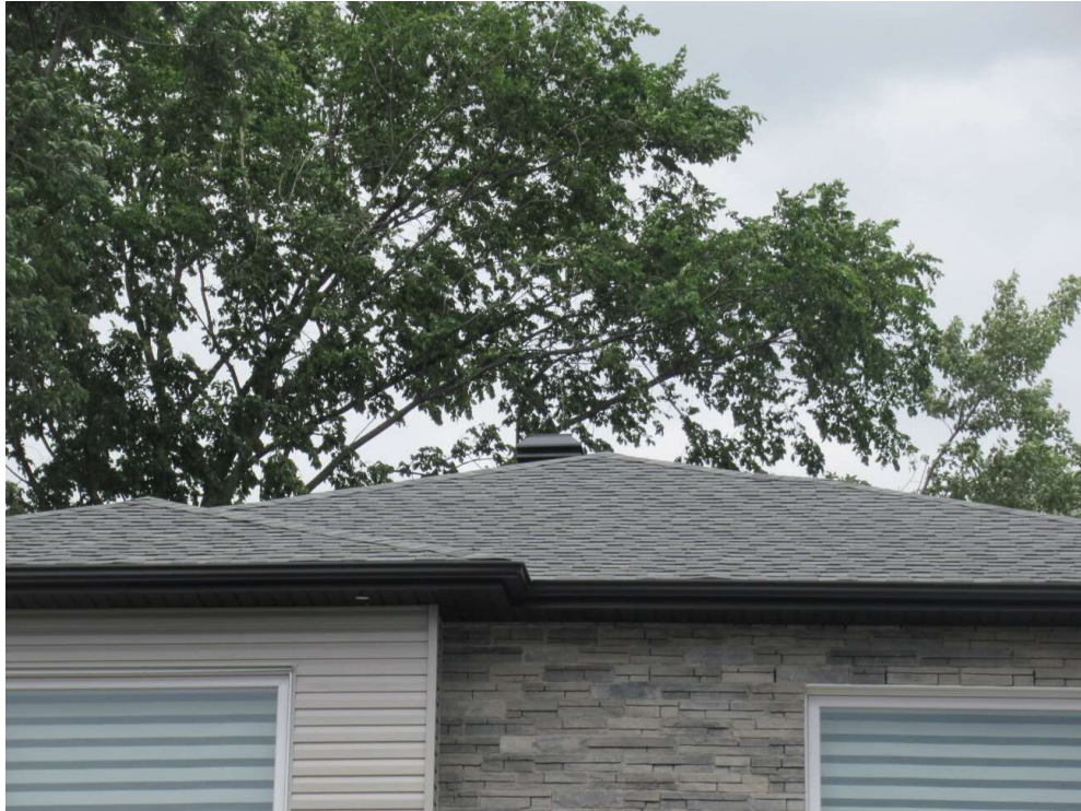
Toiture observée du sol
