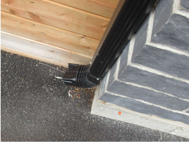
Descentes pluviales près de la fondation
