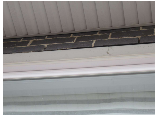
Fascias du bâtiment
