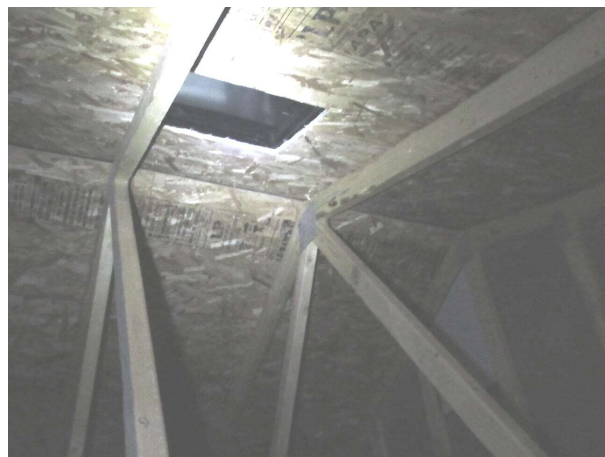
Contreventement sur les fermes de toit
