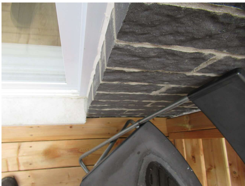
Joint d'étanchéité de la porte sans déficience apparente
