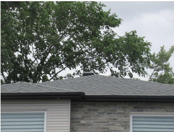
Fascias du bâtiment
