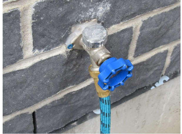
Aucun dommage observés sur les robinets extérieurs
