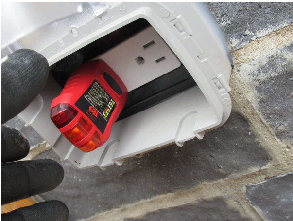
Prise de courant extérieure sans DDFT
