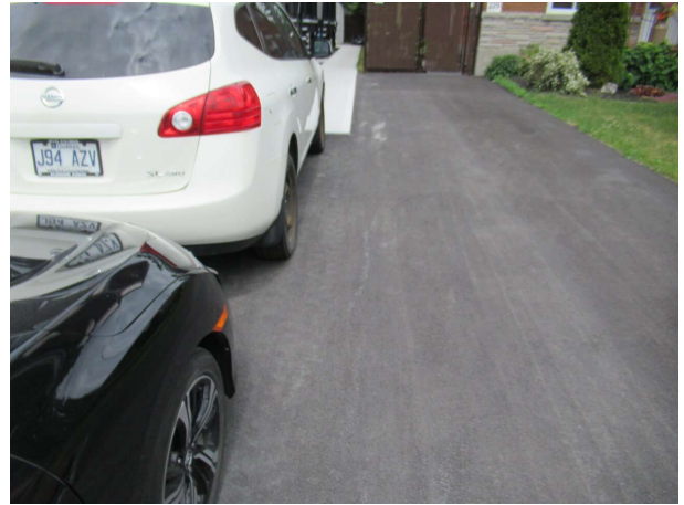
Entrée d'asphalte sans déficience apparente
