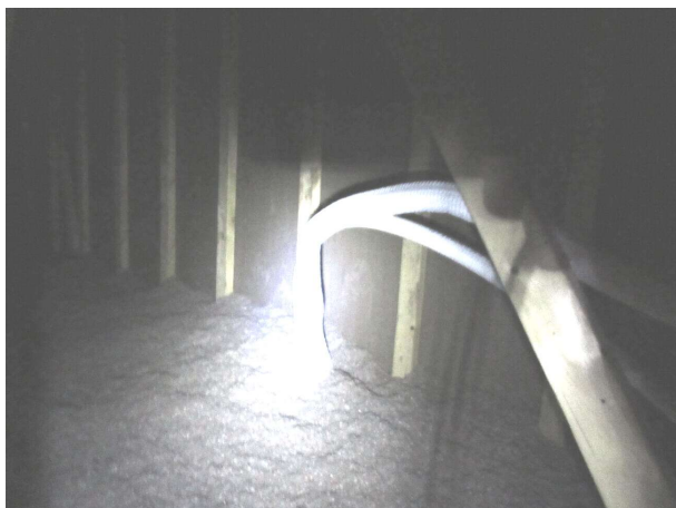
Aucun cernes ou signe d'infiltration apparent
