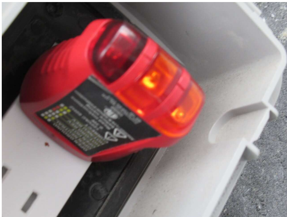
Prise de courant extérieure sans DDFT
