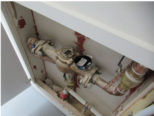
Inspection limitée du système de plomberie
