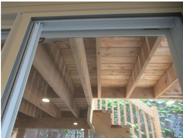
Poutre et poteaux de la terrasse
