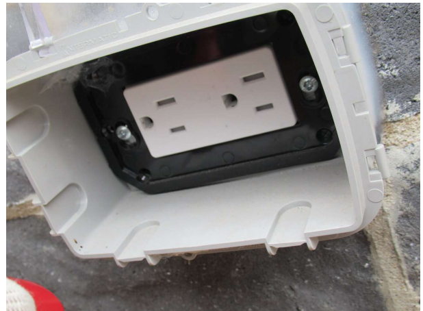
Prise de courant extérieure sans DDFT
