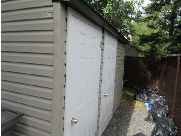
Limitation sur l'inspection du cabanon
