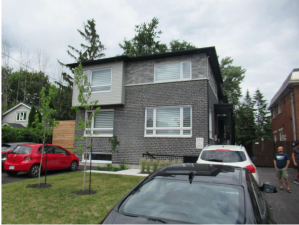
Drainage naturelle de l'eau
