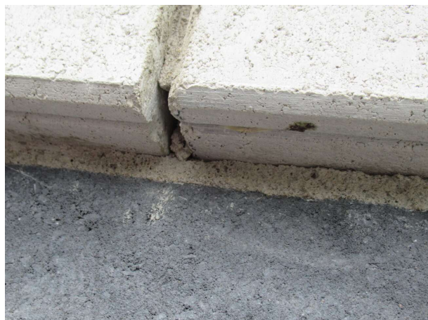
Allège en briques avec joints exposés
