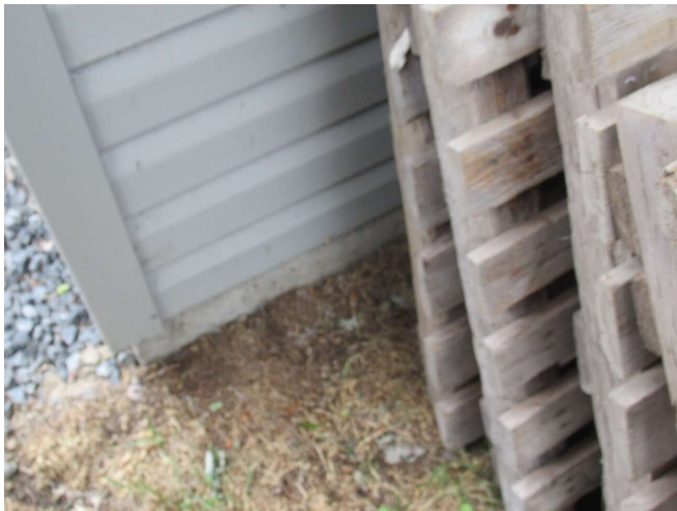
Limitation sur l'inspection du cabanon
