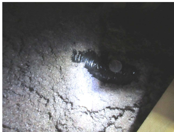
Aucune anomalie sur l'isolation
