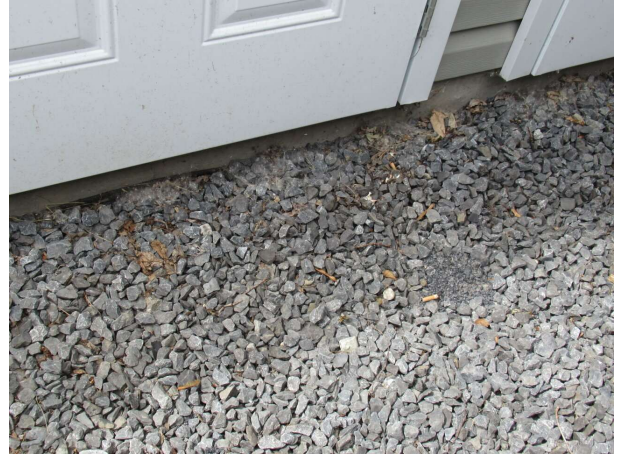
Limitation sur l'inspection du cabanon
