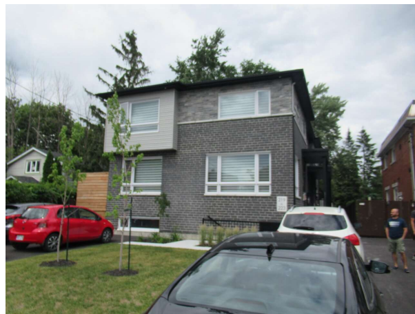
Hauteur excessive de la toiture
