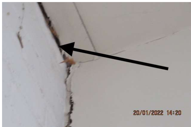
Ouverture entre la jonction de la rallonge et le bâtiment principal
