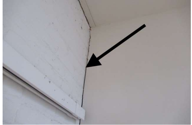
Ouverture entre la jonction de la rallonge et le bâtiment principal
