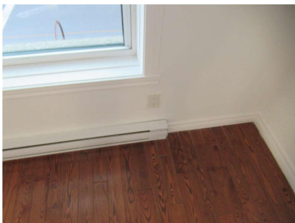
Aucune déficience apparente aux plinthes électriques
