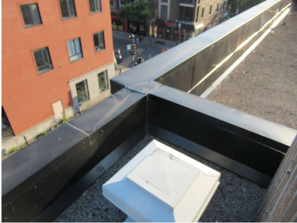
Section inaccessible dans l'entre-toit
