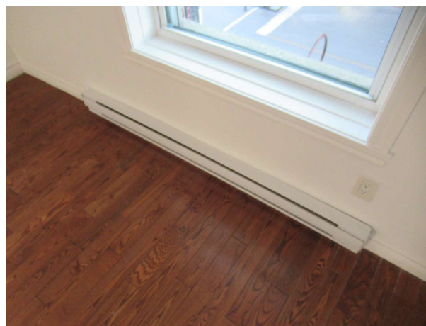
Aucune déficience apparente aux plinthes électriques
