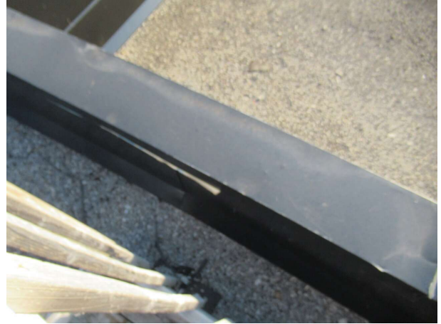
Section inaccessible dans l'entre-toit
