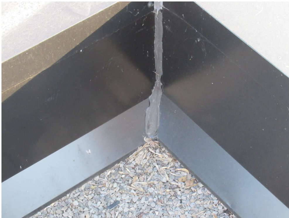
Section inaccessible dans l'entre-toit
