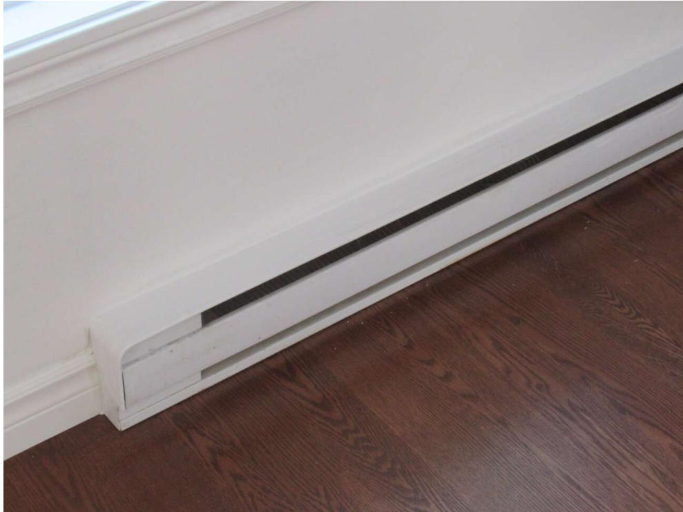
Aucune déficience apparente aux plinthes électriques
