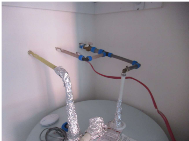
Inspection limitée du système de plomberie
