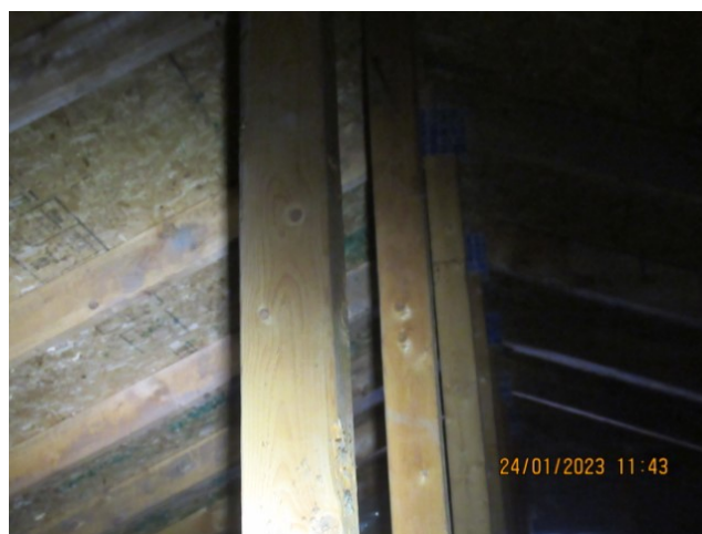
Aucun dommage observé
