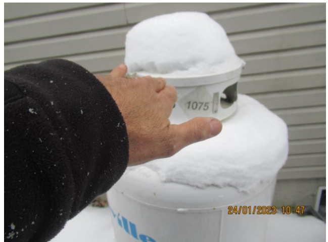
Bombonne de gaz propane qui n'est pas au niveau
