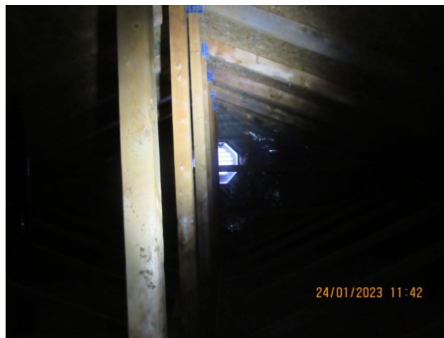
Ventilation des pignons non bloqués en présence d'un Maximum
