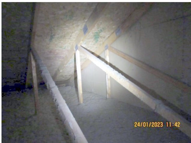
Aucun dommage observé
