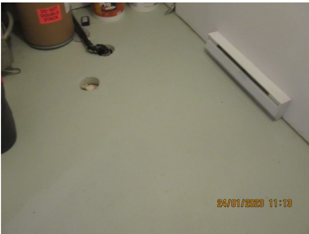
Aucun dommage observé
