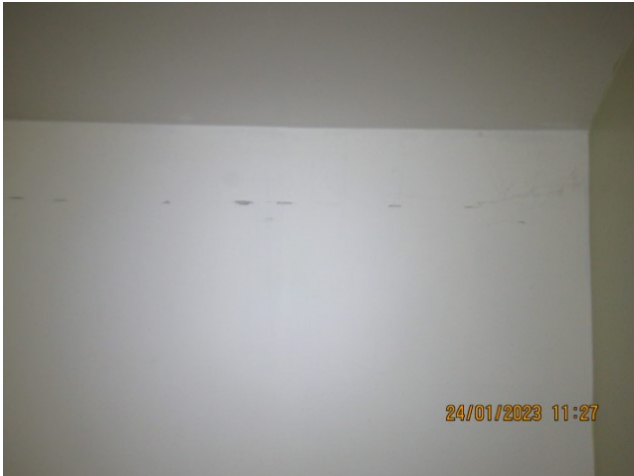
Isolation et pare-vapeur des murs non visibles
