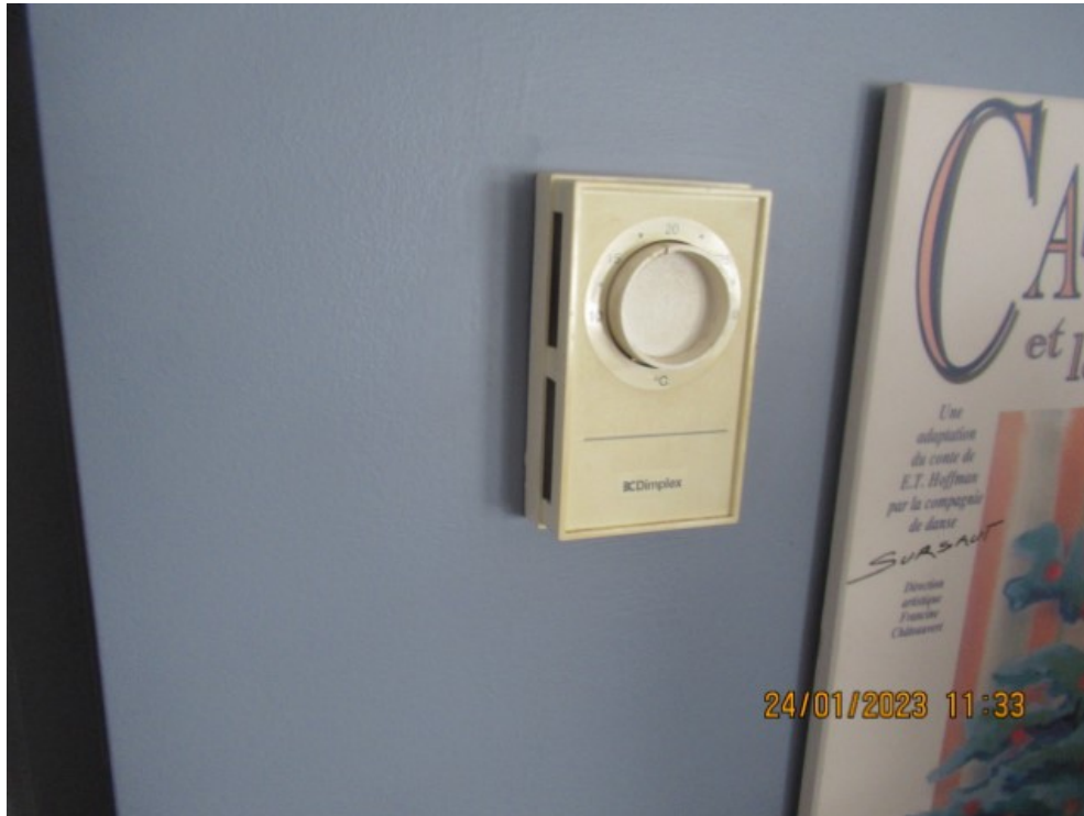
Exemple de thermostat mécanique à remplacer
