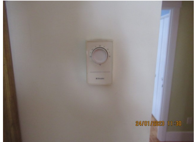
Exemple de thermostat mécanique à remplacer
