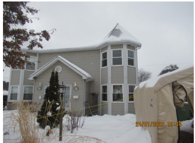
Entrée de stationnement et trottoir caché par la neige
