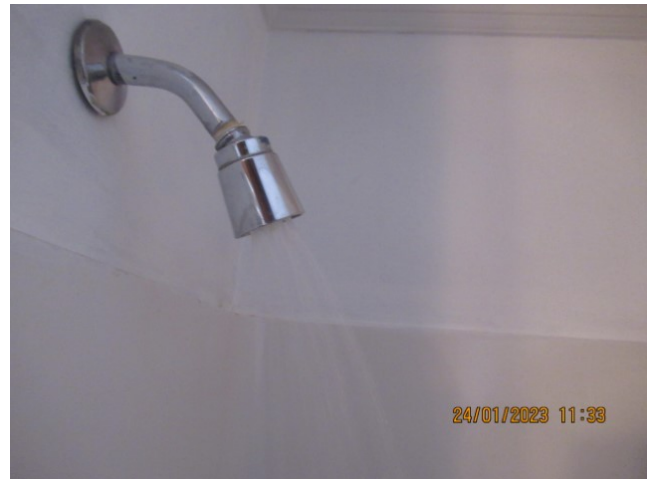
Aucun dommage observés sur les appareils et robinets
