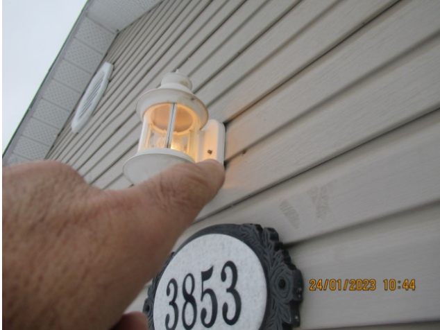
Scellant au pourtour des ouvertures à entretenir
