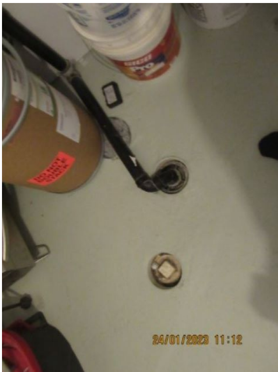
Aucune déficience apparente au drain de plancher
