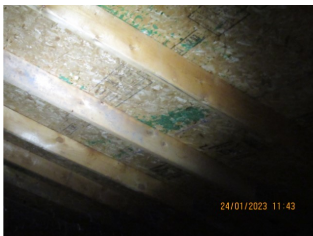
Aucun dommage observé
