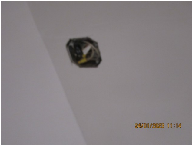
Boîtier et les fils exposés
