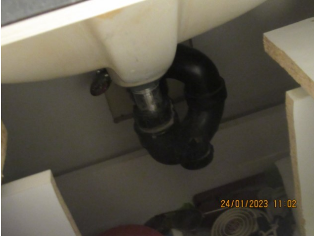
Aucun dommage ou fuites apparentes
