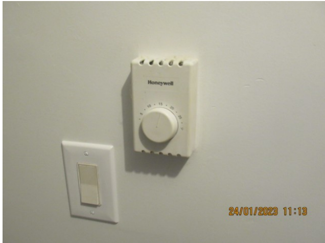
Exemple de thermostat mécanique à remplacer
