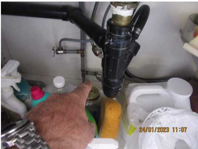
Conduit de distribution du bec du robinet de cuisine qui fuit
