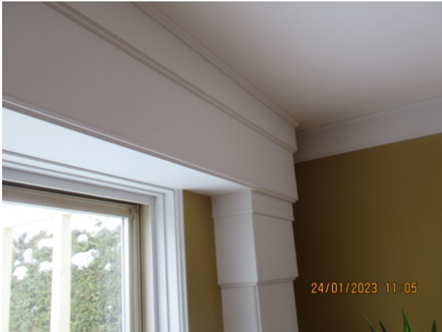
Aucune déficience observée aux plafonds
