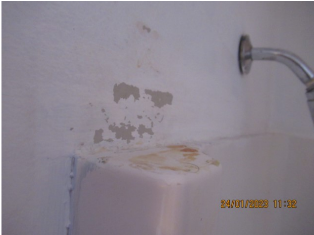
Revêtement de la douche inapproprié et endommagé
