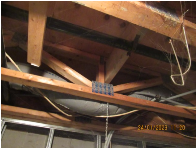
Aucun dommage apparent
