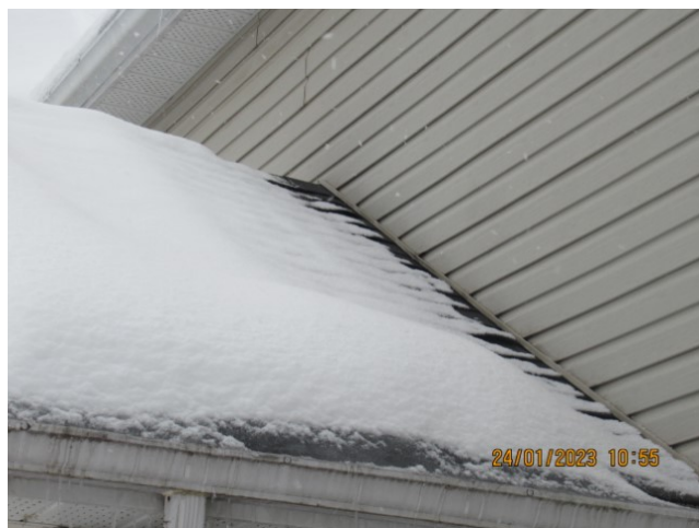
Toiture observée du sol
