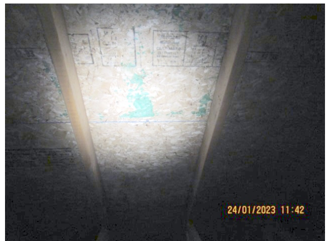
Aucun dommage observé
