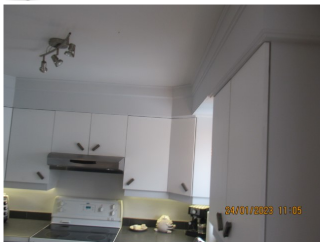
Inspection limitée sur les murs
