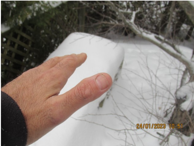
Muret de soutènement qui s'affaisse
