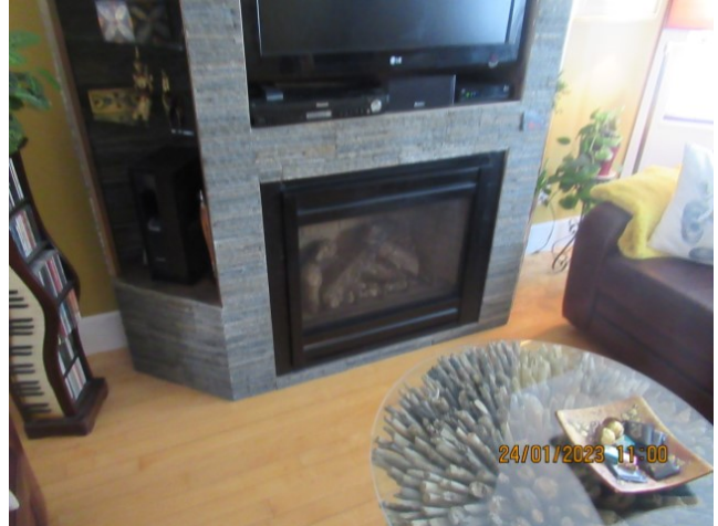
Inspection limité de la cheminée du foyer au gaz
