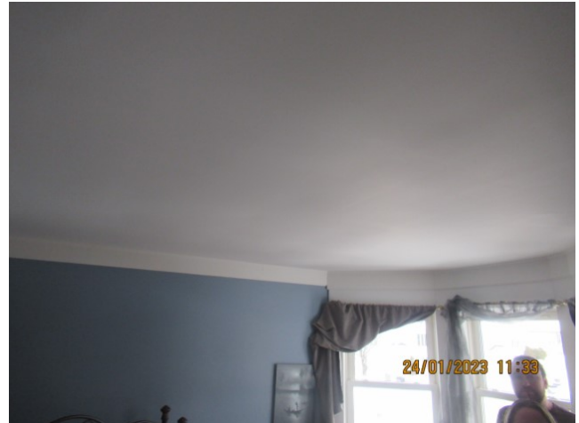
Aucune déficience observée aux plafonds
