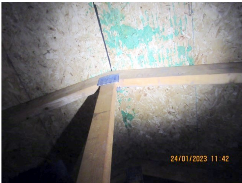
Aucun dommage observé
