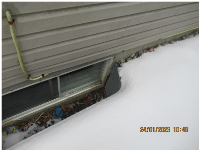
Neige sur les murs de fondation extérieurs
