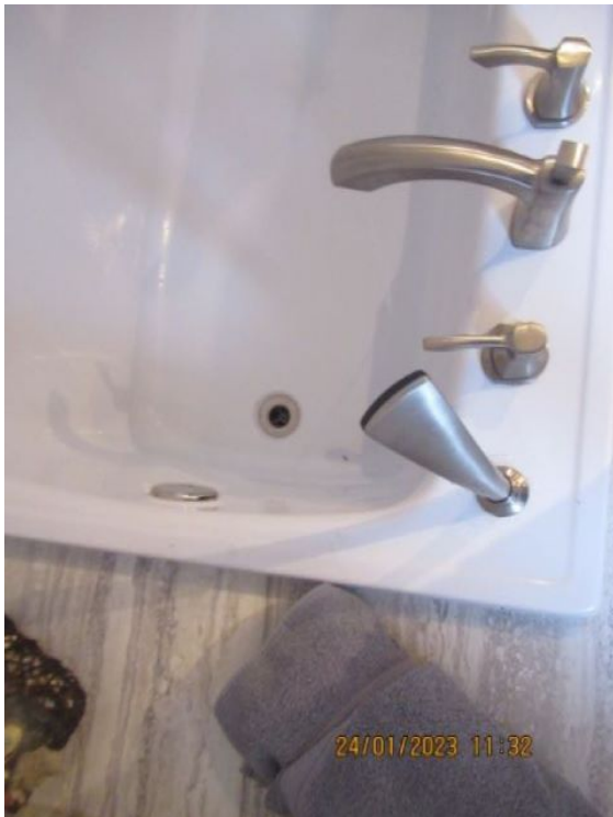
Aucun dommage observés sur les appareils et robinets
